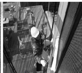
同じくロープ作業によって塗装を行う
