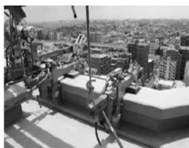
屋上にゴンドラを支える架台設置
