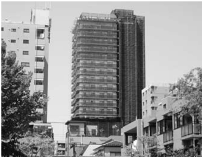
ゴンドラ仮設で作業する10階から22階の部分
