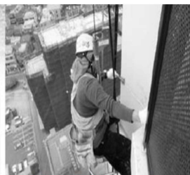
単独ゴンドラでは建物のコーナー部分でロープ作業もある
